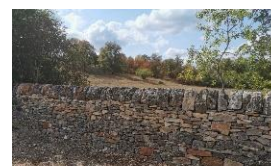
Le mur a été parfaitement réparé
